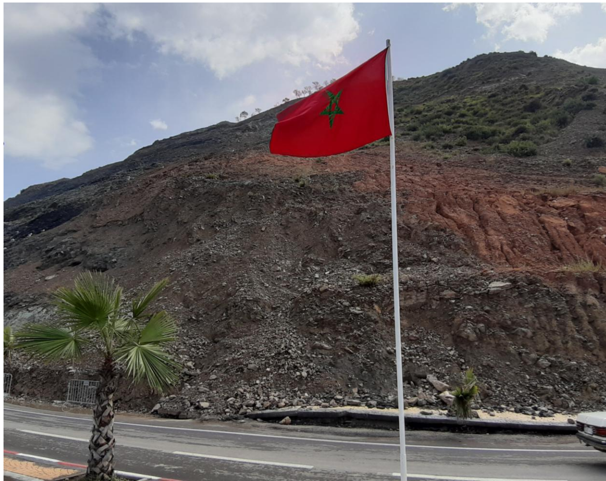
Photo du glissement de l'entrée de Jebha en 2020
